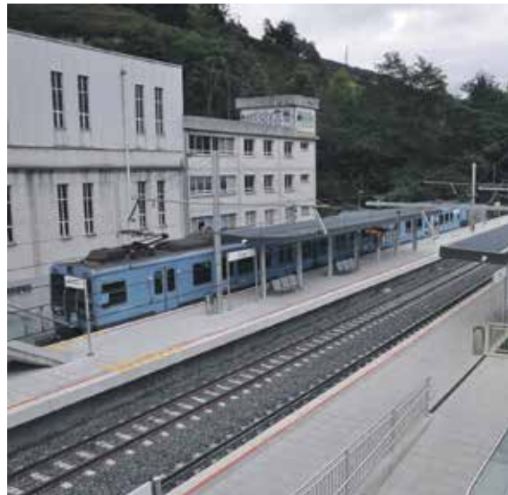
Herrera - Loiola que permite aumentar los servicios y frecuencias del nuevo tramo desdoblado Añorga - Errekalde.
